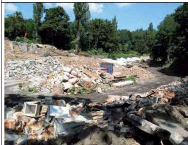
Area della fabbrica dopo la demolizione
