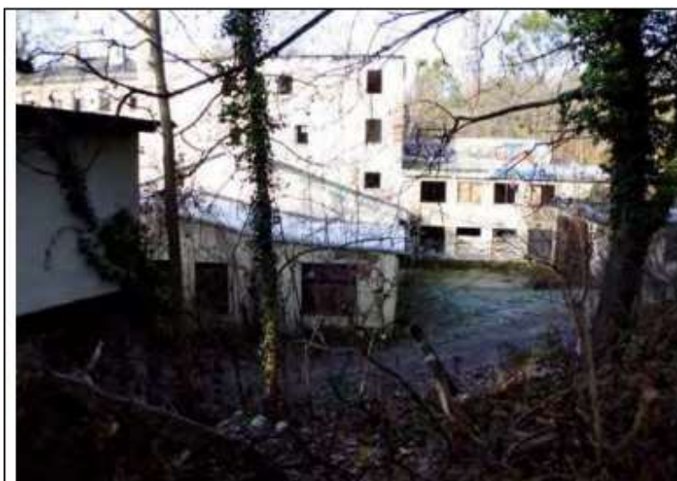
Radeberger Strasse - Fabbrica di cappelli dismessa prima della demolizione
